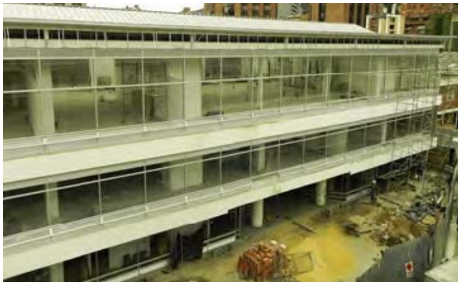
Fuente: Adecuación Bloque C - Nivel Central.
