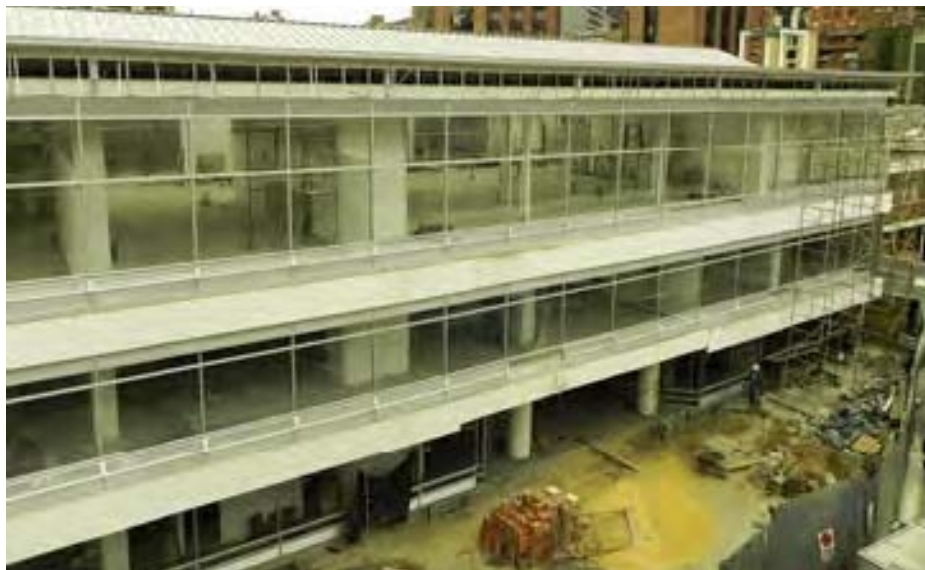
Fuente: Adecuación Bloque C - Nivel Central.
